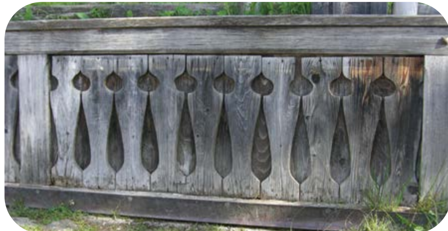
L'azione combinata di sole e acqua provoca il cosiddetto "effetto pettine".
